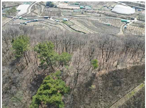
사면 상부 전경
