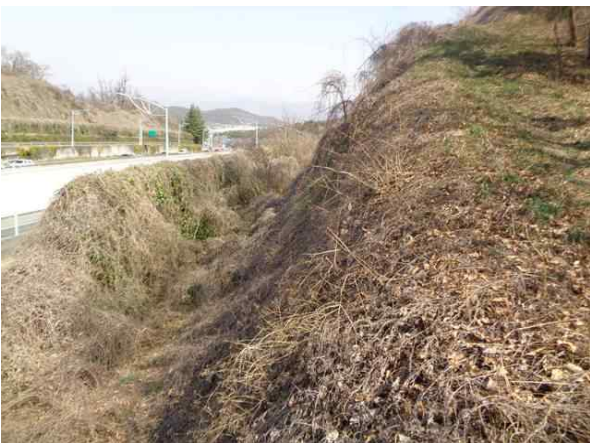
낙석방지울타리 및 하부 전경
