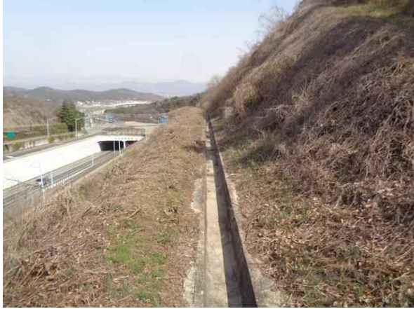
1소단 배수로 전경
