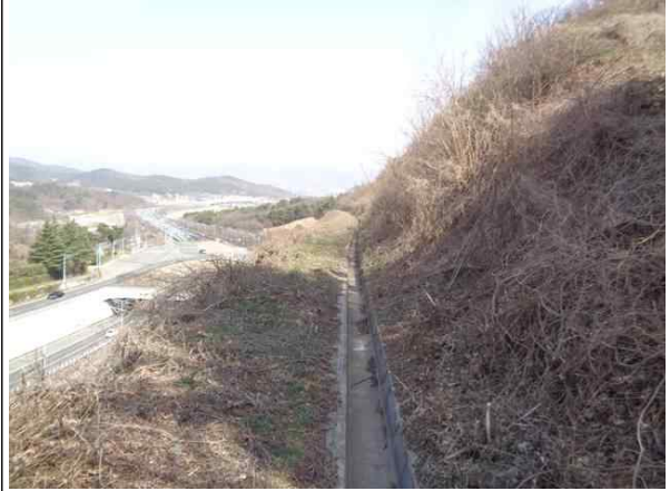
2소단 배수로 전경
