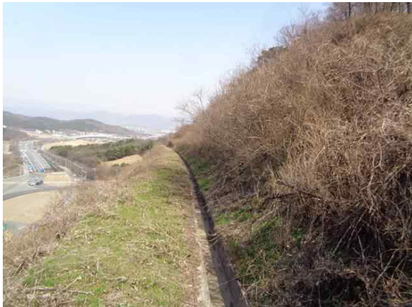
3소단 배수로 전경
